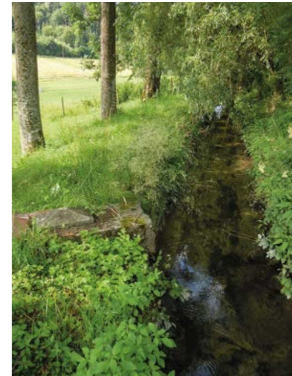
Der Mühlkanal oberhalb des Tannenschorrenales liefert Wasserkraft für die beiden Klostermühlen auf dem Tannheimer Mühlberg.
