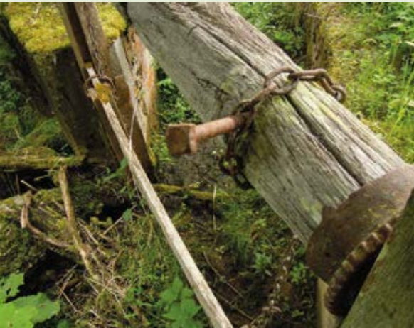
Beispiel einer einfachen gezimmerten Anlage: der Fallenstock im Kanal der Sägemühle Grub bei Wangen
